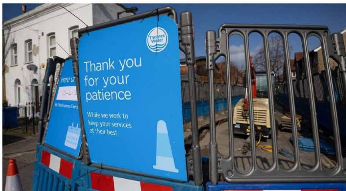
Una obra de Thames Water. Foto: Bloomberg.
