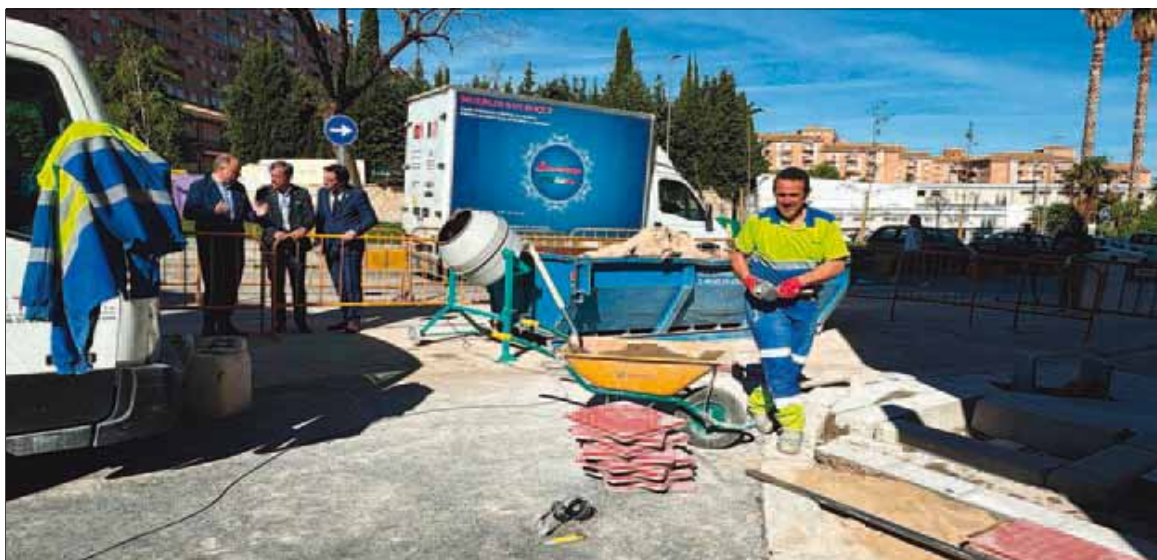
REPARADO EN DOS SEMANAS. Agustín González y Antonio Losa visitan las obras en la Avenida de Arjona.
