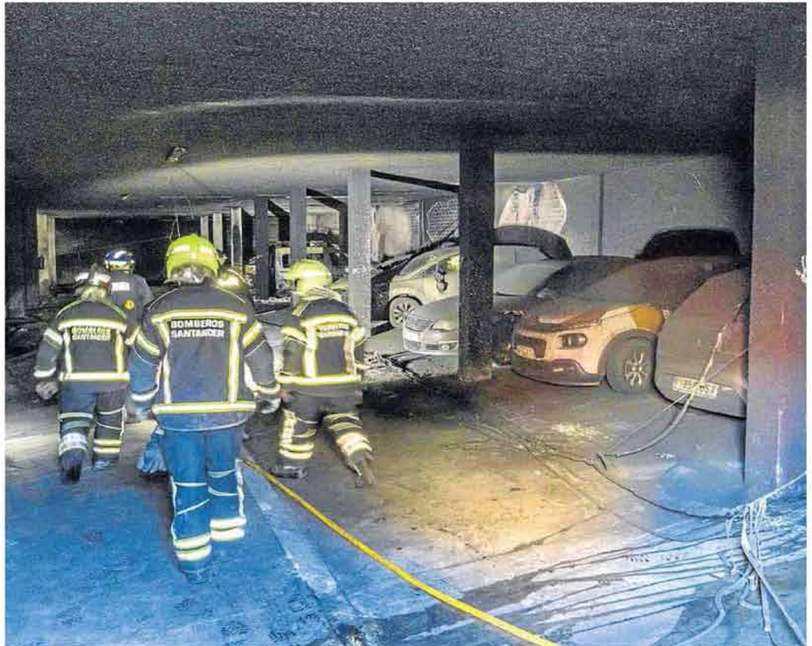
Oscuridad. Los bomberos evalúan los daños producidos por el fuego en los automóviles y en la estructura del edificio. FOTOGRAFÍAS: ROBERTO RUIZ
